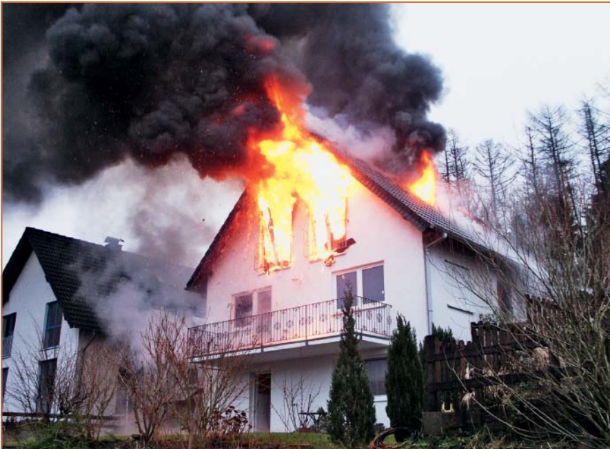
Abb. 4: Der Einstufung als Raum mit erhöhter Brandgefahr folgt unmittelbar die Bewertung als Sonderbau. Bei einer strengen Auslegung wären selbst manche Wohngebäude als Sonderbauten einzustufen.
